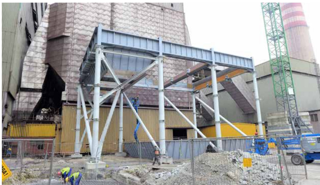
Zdjęcia przedstawia konstrukcję wsporczą filtra hybrydowego nr 7.
